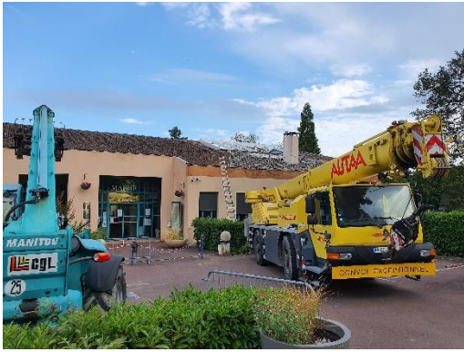
travaux du patio,
